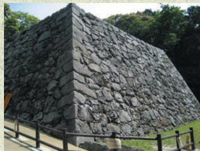
古式穴太積みの技術がいかされた復元天守台
