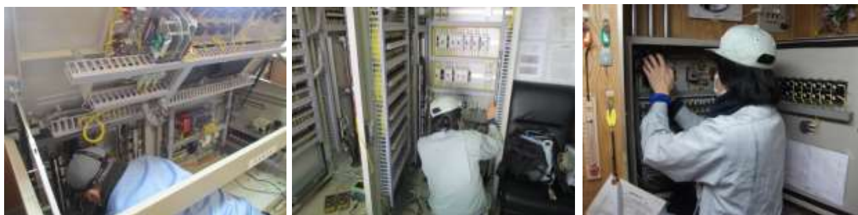
制御盤点検
