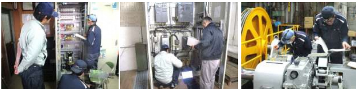
制御盤点検
