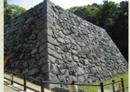
古式穴太積みの技術がいかされた復元天守台
